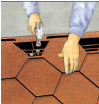
3. Hver enkelt plade sømmes med 4 søm. Et søm oven for hvert indsnit samt på hver side af styresporet, så næste række dækker sømningen. Ved taghældninger over 45° og i kantzonen (1 meter rundt langs hele bygningen) anvendes 2 søm med 40 mm mellemrum på hver side af styresporet, 6 søm/plade.
