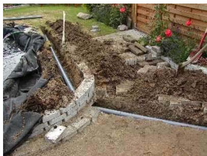
14 meter afløbsrør til kloak
